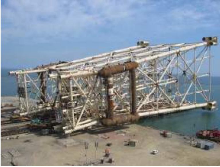
Şəkil 5.9 DərSG-YBQTTP-nın dayaq bloku barja yüklənərkən
