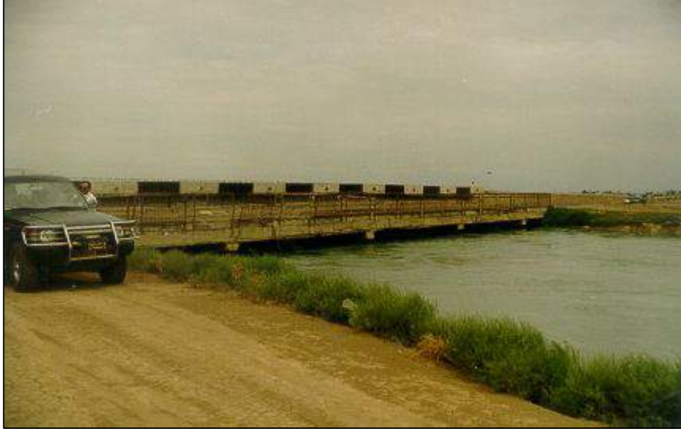
Şəkil 12 Qarabağ kanalı
