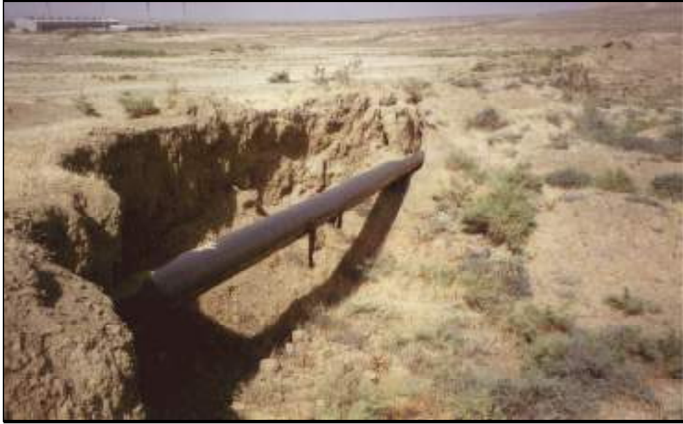
Şəkil 9 Dərədən boru kəmərinin çəkilməsi nəticəsində üzə çıxma
