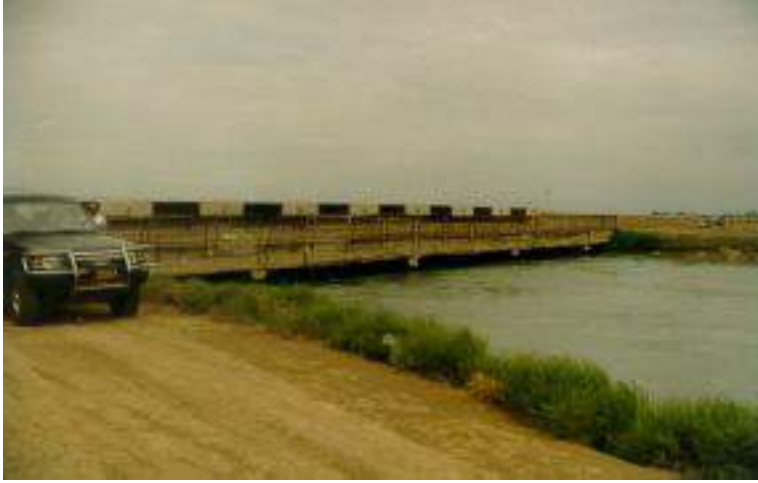
Şəkil 2 Qarabağ kanalı
