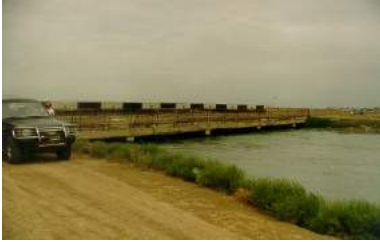
Şəkil 8-16 Qarabağ Kanalı
