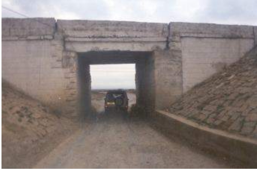
Şəkil 8-26 Dəmir yol xətti altından tipik keçid
