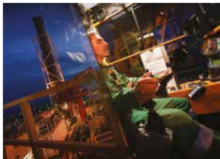
▲ Kran operatoru Qərbi Azəri platformasında yükqaldırma işi icra edir.
