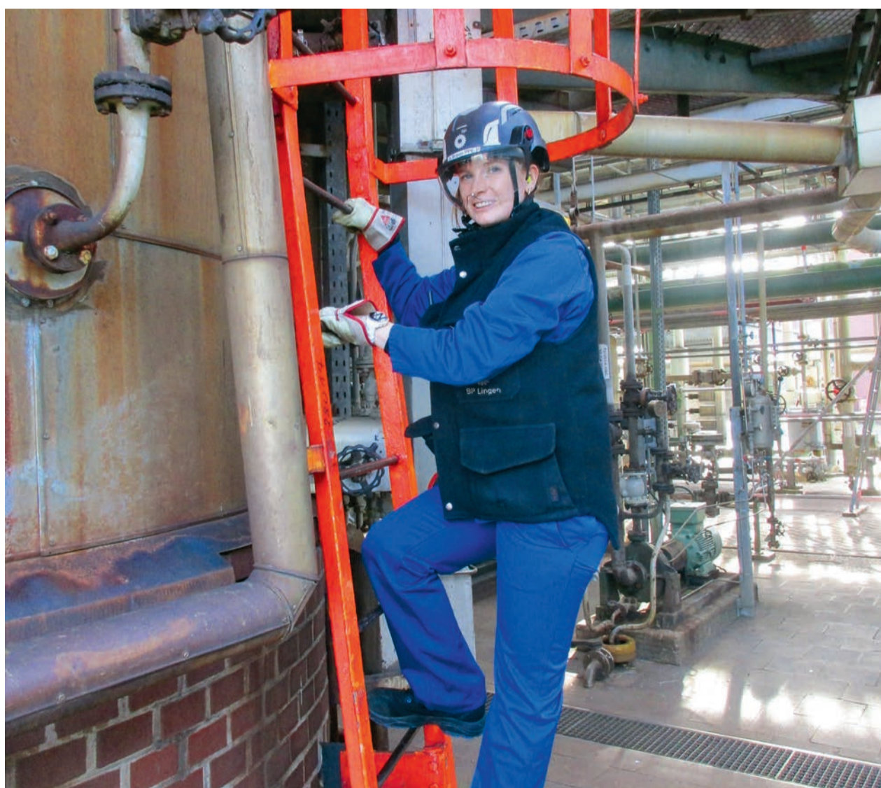
Rauf auf die Steigleiter – im Rahmen des Kontrollrundgangs für Anna erprobte Routine.
