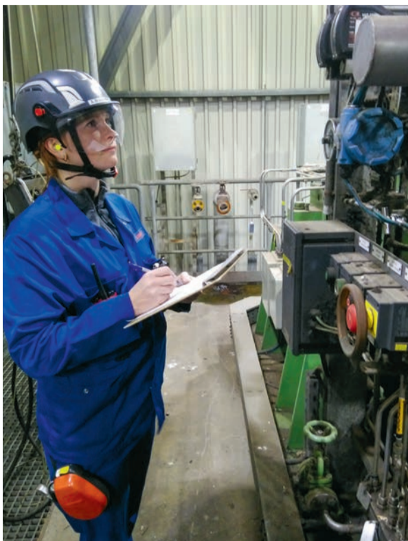
Ein prüfender Blick auf die Anlagen: Anna kontrolliert Drücke und Temperaturen.
