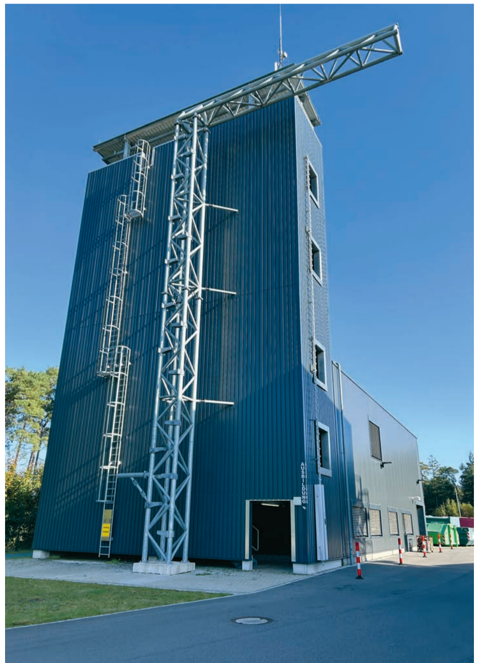
Der 23 Meter hohe Übungsturm der Werkfeuerwehr mit seinem 10 Meter langen Ausleger.
