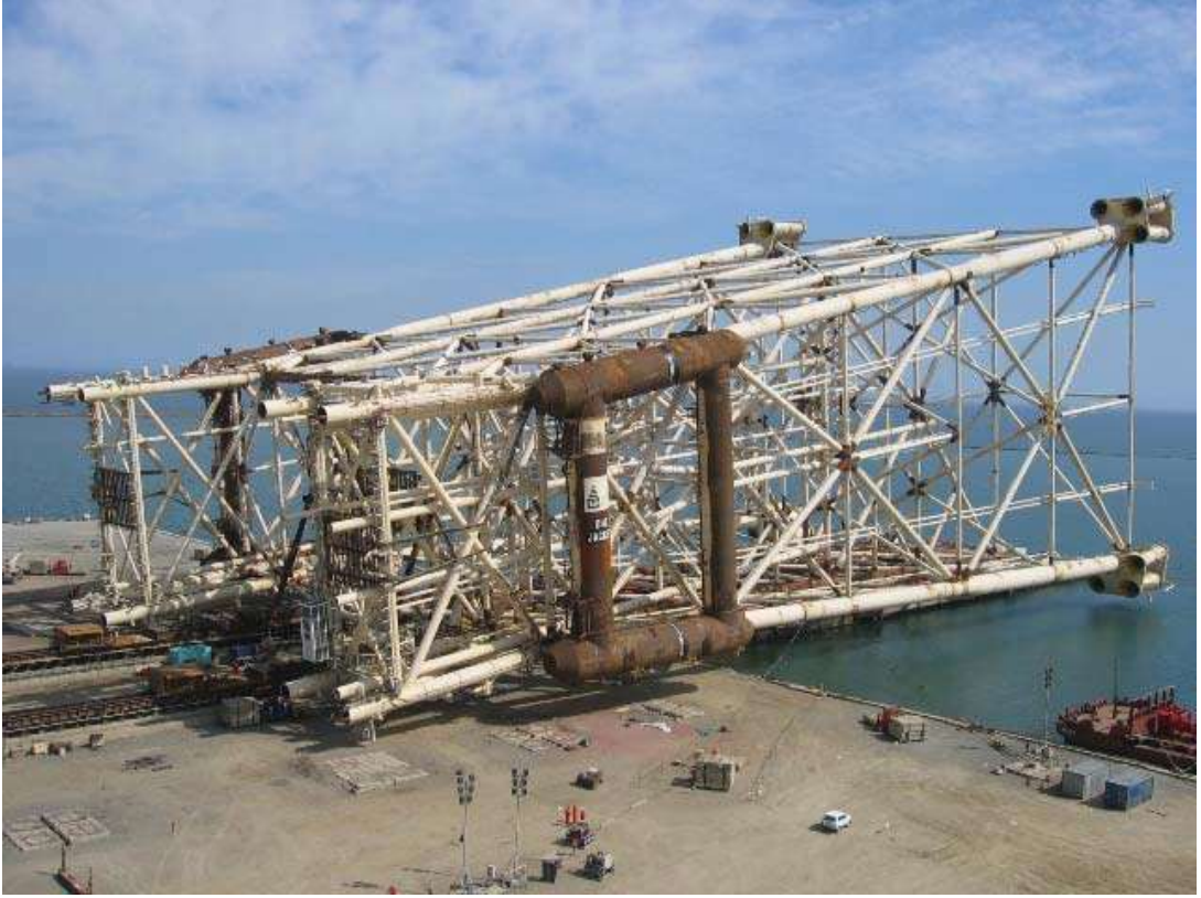
Şəkil 5.7: DərSG-YBQTT platformasının dayaq bloku yükləmə zamanı
