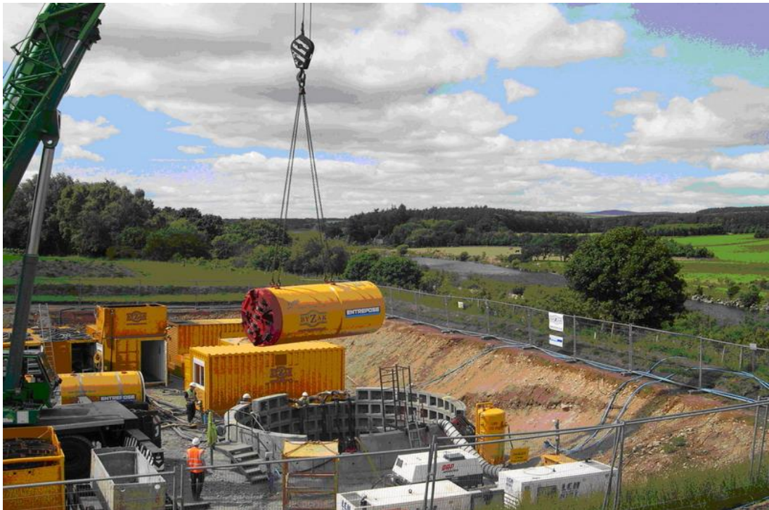
სურათი 5-19: გვირაბის საბურღი მანქანის (TBM) ჩაშვება შემავალ შახტში
