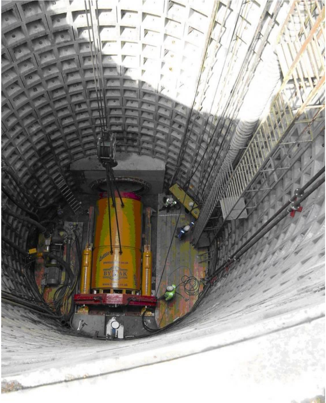
სურათი 5-20: ჰიდრავლიკური მიწოლის დანადგარი შემავალ შახტში
