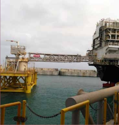
الممر الرابط بين منصة تسييل الغاز الطبيعي والمحطة المركزية
