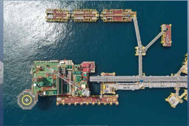
منصة الوحدات السكنية ومرافق الخدمات بعد تثبيتها في المحطة المركزية
